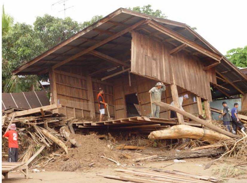
ความเสียหายที่เกิดจากอุทกภัย ที่ อ.แม่ระมาด จ.ตาก พ.ศ.2547
